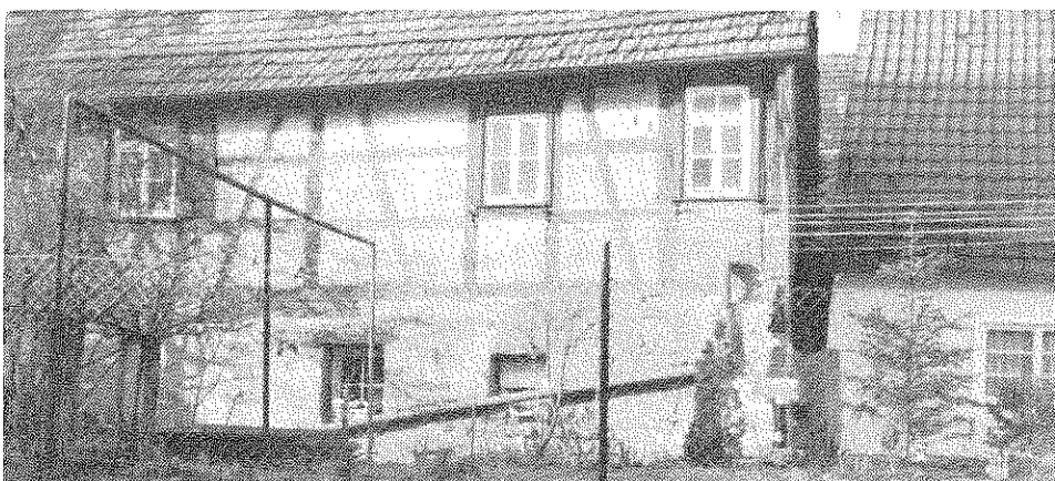
Abbildung von der Ostseite des Hauses, wie es sich um 1976 beim Kauf darstellte. Der ehemalige Stall auf der Nordseite ist schon abgerissen, die Fassade nicht flächenerputzt, lediglich die mit Feldsteinen ausgeriegelten Gefache.
