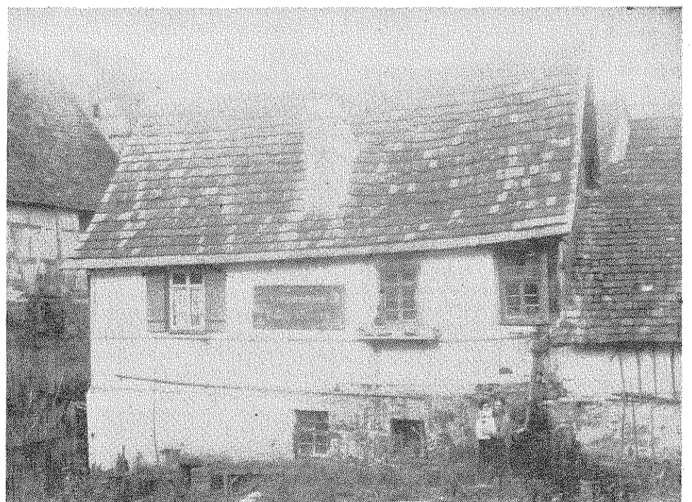
Ältestes Foto des Mayer-Hauses (Original im Stadt- oder Schiller-Archiv). Das Bild entstand vor 1909, weil es noch den alten, dicken, bestiegbaren mit einer Platte abgedeckten Kamin und die hölzerne Schrifttafel (1862) zeigt.
